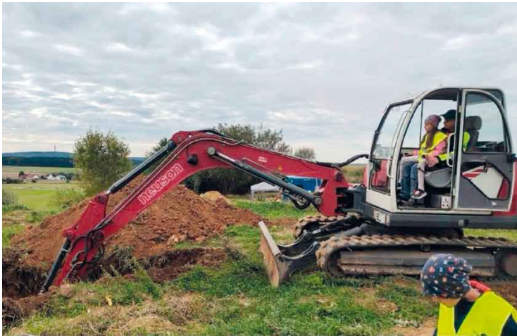
Baumaschinen-Tag mit dem Bauhof Deining
